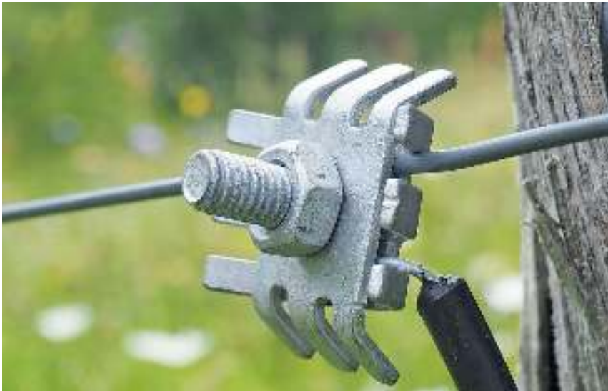
Wichtig ist eine gute Verbindung aller Zaunelemente, bewährt haben sich beispielsweise Schraubklemmen. Foto: DVL
