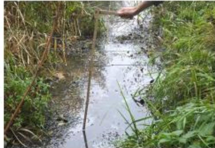
**Bild 7 – Vertikaler Drahtvorhang am Beispiel einer Grabenüberquerung**
