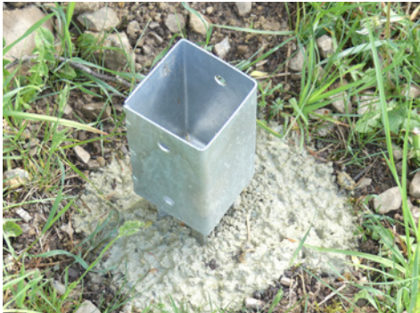
Abb. 6: Das Loch für die Pfostenhülse als Erdung wurde mit bentonithaltigem Katzenstreu aufgefüllt, das eine ähnlich gute Wirkung wie Bentonit hat. Foto: F. Lamprecht
