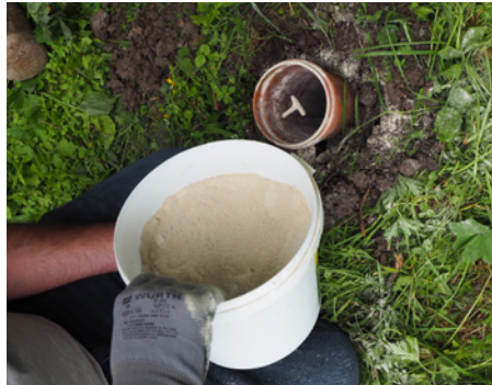
Abb. 7: Das Erdloch um einen Erdungsstab wird mit Bentonit verfüllt und gewässert. Das umgebende Rohr wird nach Einfüllen und Verfestigung des Bentonits wieder entfernt. Foto: DVL
