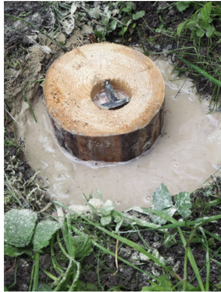
Abb. 11: Ein Holzzylinder mit einem Loch in der Mitte kann über aus dem Erdreich ragende Erdungsstäbe gesteckt werden, um die Unfallgefahr zu verringern. Foto: DVL
