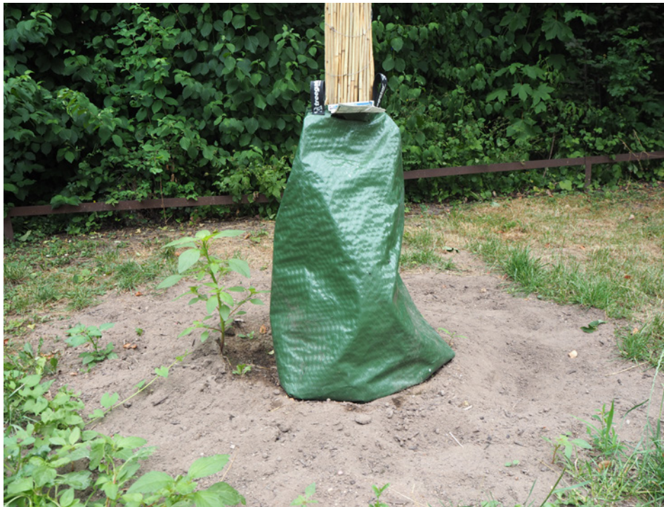
Abb. 5: Wasserbeutel, wie sie auch zur Baumbewässerung eingesetzt werden, können einen Erdungsstandort feucht halten. Foto: DVL
