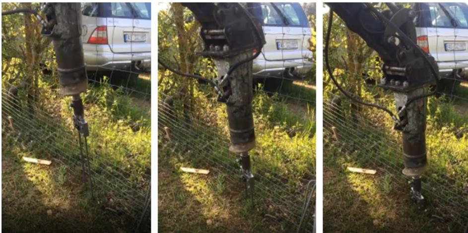
**Abb. 5:** Einrammen von Armierbögen mit einem Bagger. Die Bögen werden in die unterste Masche des Zaunes eingefädelt und bis zum Erdboden in den Untergrund eingedrückt. Durchmesser der Armierbögen: 12mm (geringerer Durchmesser wurde getestet, verbog sich aber beim Einrammen). Die Bögen sind 70cm lang, je nach Bodenbeschaffenheit musste hier teilweise auf 50/60cm gekürzt werden. Aufnahmen: A. Kosel.
