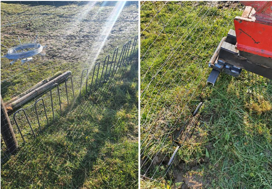
**Abb. 6:** Weiteres Beispiel zum maschinellen Einbringen von Armierbögen. Die Bögen haben einen Durchmesser von 12 mm und eine Schenkellänge von 60 cm. Pro laufendem Meter werden 5 Bögen eingebracht. Fotos: J. Hofbauer.
