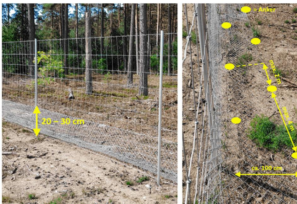
**Abb. 3:** Die ausgelegte Drahtschürze muss sehr gut am Zaun verankert werden, arbeits-erleichternd kann das Hochführen der Schürze auf circa 20 bis 30 cm am Zaun sein. Erdnägel sichern die feste Verankerung der Zaunschürze (rechts im Bild). Hinweis: Beim abgebildeten Aufbau fehlt ein Überkletterschutz, zum Beispiel durch einen stromführenden Leiter an der oberen Außenseite des Zauns. Fotos: F. Faß
