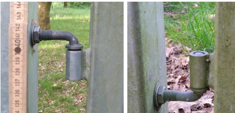
**Abb. 8:** Das eine Scharnier ist im Beispiel umgekehrt angebracht, sodass durch ein etwaiges Anheben des Tores kein Aushängen erfolgen kann. Foto: J. Martens
