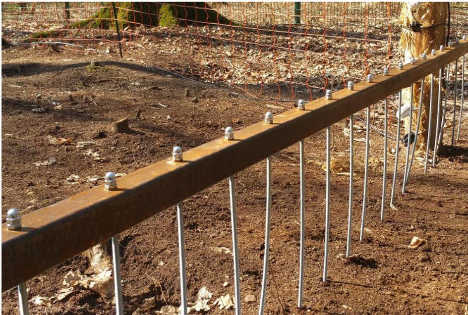
**Abb. 4:** Sogenannter „Kamm“. Die senkrechten Stäbe sind 40 cm in das Erdreich getrieben und ragen nach oben ca. 30 cm heraus (daran schließen stromführende Litzen an). Die Wölfe konnten das Hindernis trotz intensiver Grabungen nicht überwinden. Foto: F. Faß
