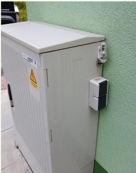
**Bild:** Trafo-Kasten mit Außensteckdosen für das Weidezaengerät. Foto: K. Ebinger
