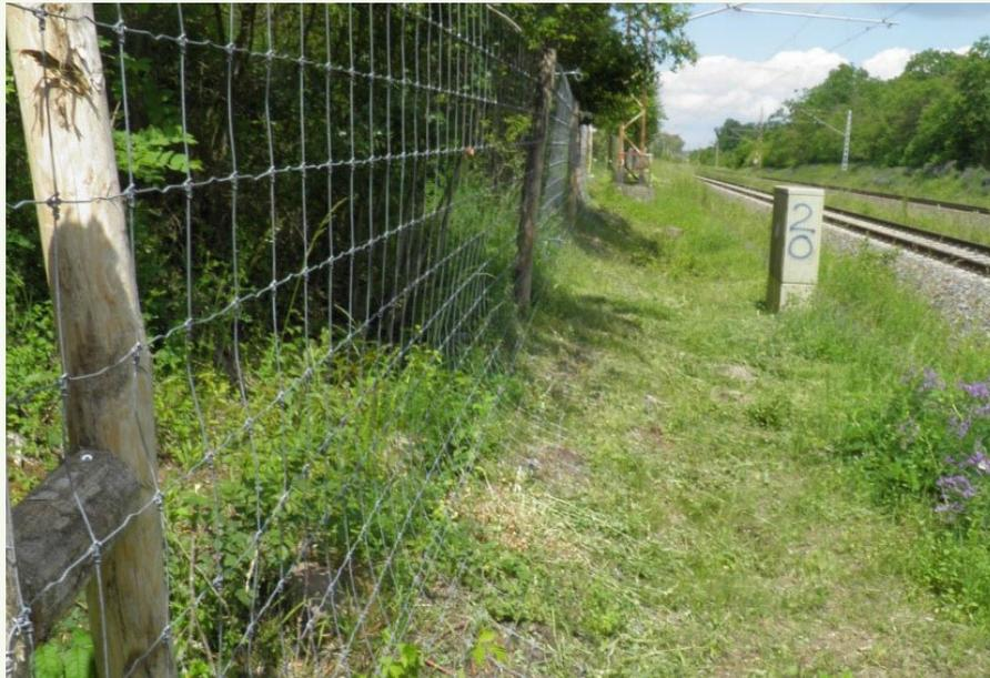
**Bild:** Zaun neben der Bahnstrecke; Untergrabungsschutz durch umgebogenes Drahtgeflecht.
