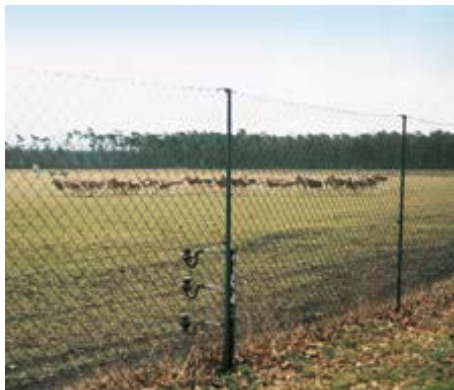
Maschendrahtzaun mit nach innen vorgesetzten Elektrodrähten.
