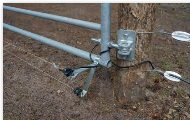
Abbildung 14: Tor mit zusätzlicher Elektrifizierung als Schutz vor Untergraben bzw. Überklettern (© links: G. Herkert, © rechts: F. Faß)
