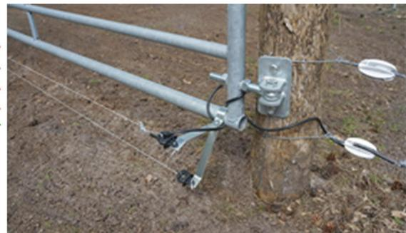
**Bild 13 – Tor mit zusätzlicher Elektrifizierung als Schutz vor Untergraben bzw. Überklettern**
