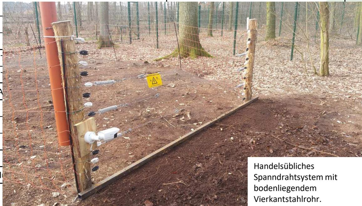
Handelsübliches Spanndrahtsystem mit bodenliegendem Vierkantstahlrohr.
